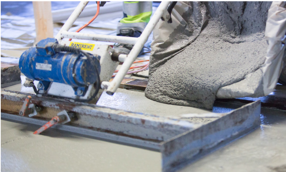
Bild 3 Kärning till vibrobalk vid gjutning av hårdbetong
