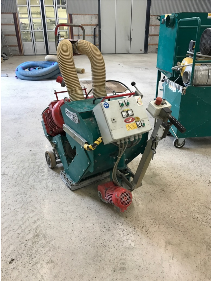
Bild 2. Stålkuleblästring av befintligt betonggolv innan gjutning
