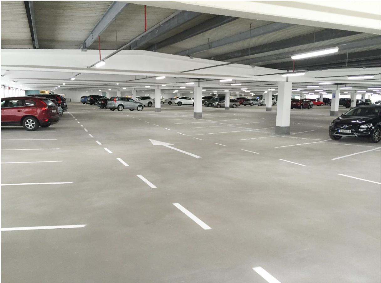
Bild 1 Garage belagt med hårdbetong
