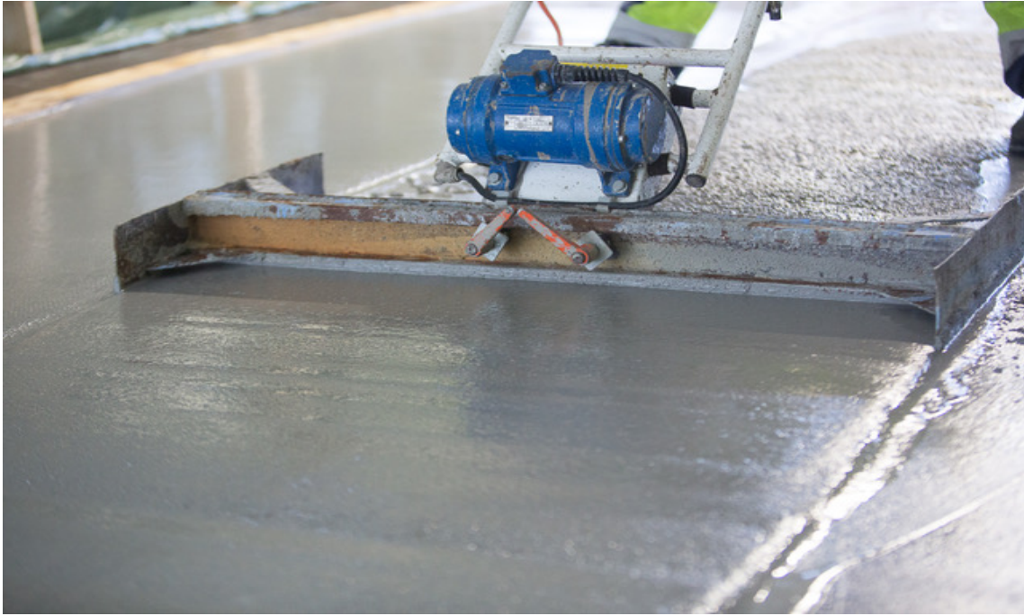
Bild 4: Utläggning med vibrobalk.
